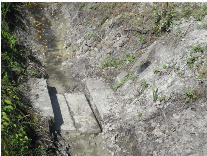
Obr. 3: Opevnění vyústění z retenční nádrže – snížené dnové dlaždice [2]
